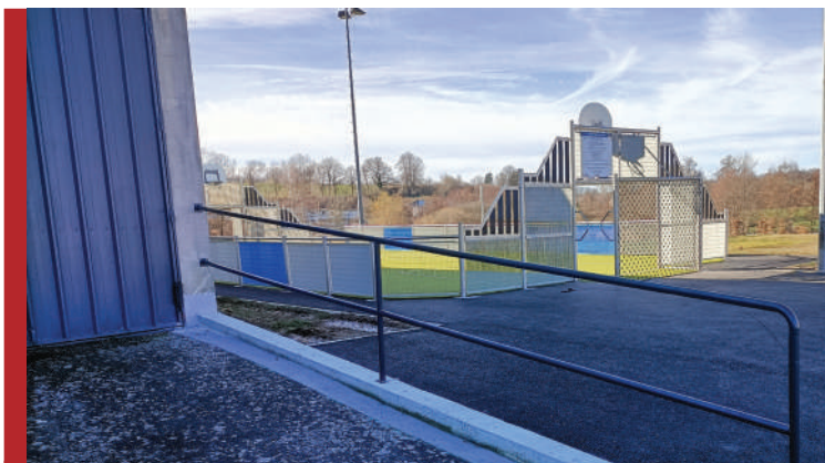
CONSTRUCTION D'UN MUR AVEC RAMPE DE PROTECTION À PROXIMITÉ DU CITY STADE
