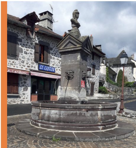
AU BOURG : Fontaine remise en eau et pergola du Cantou enlevée
